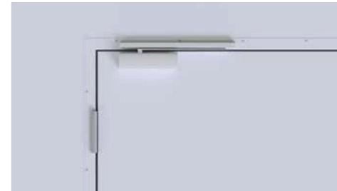
**GleitschienenschlieBer** eingebaute Gehür
